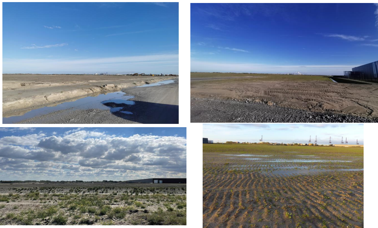
Figure 3 : Vue de la plateforme à différents stades du remblaiement (Source : dossier)
